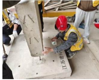
图4 剪力墙吊装
