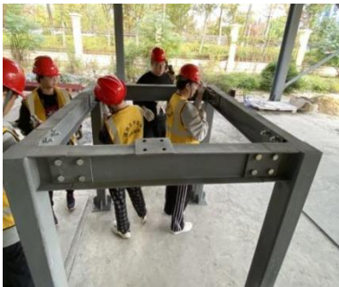
图6 钢梁、钢柱安装
