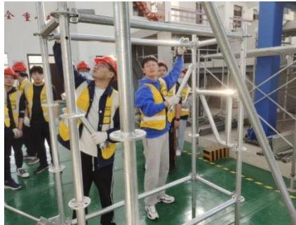
图7 盘扣支架安装
